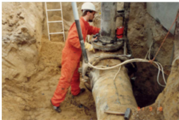
Figur 1. Nedgravet pipeline. Det lodrette rør er en del af en (kugle)ventil (Danish Oil Pipe A/S).
