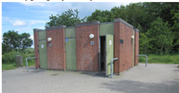
Toiletbygning på rastepladsen Nørremark.
