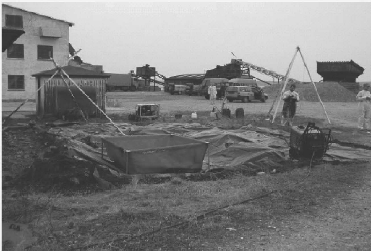
FIGUR 18: OPSÆTNING AF RENSEPLADS, UNDERLAG AF SVÆR PLASTIC FOR AT BESKYTTE UNDERGRUND MOD OLIE
