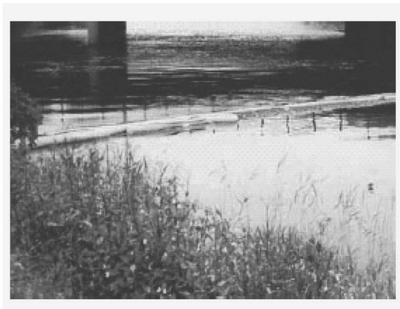
FIGUR 6: SPÆRRING MED OPSUGNINGSMIDDEL
