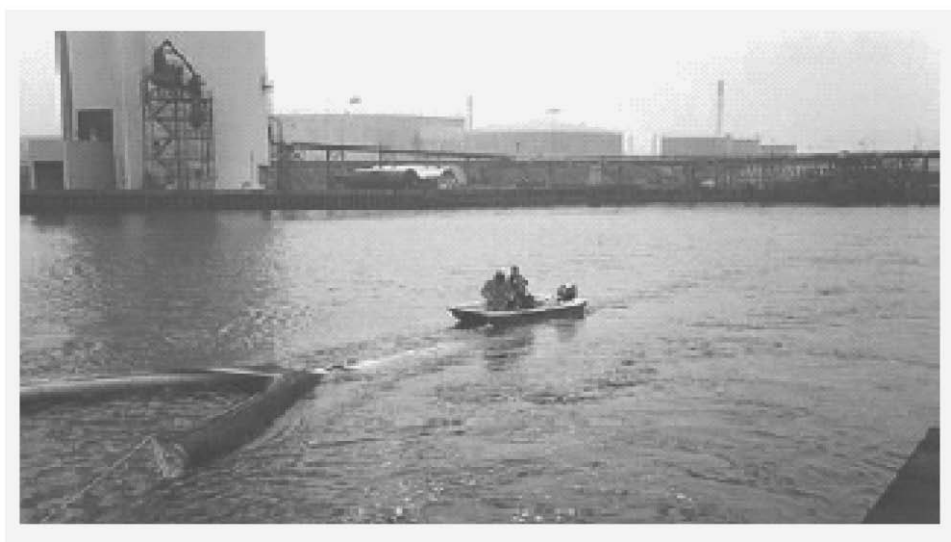
FIGUR 16: OLIE TRAWL, TRAWLPOSEN MED OPSAMLET OLIE ER VED AT BLIVE FRIGJORT
