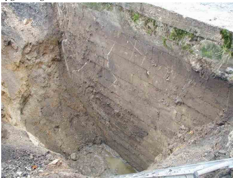
Foto 35: Ved beholdere uden kabler kan opgravningsstedet vælges frit. Her er gravet op ved en blokstensbeholder.
