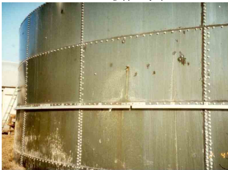
Foto 24: Stålbeholder med væg af flade profiler. Nogle stålbeholdere er som rustbeskyttelse glaserede, men hvis glasuren beskadiges, rustet stålet meget hurtigt.
