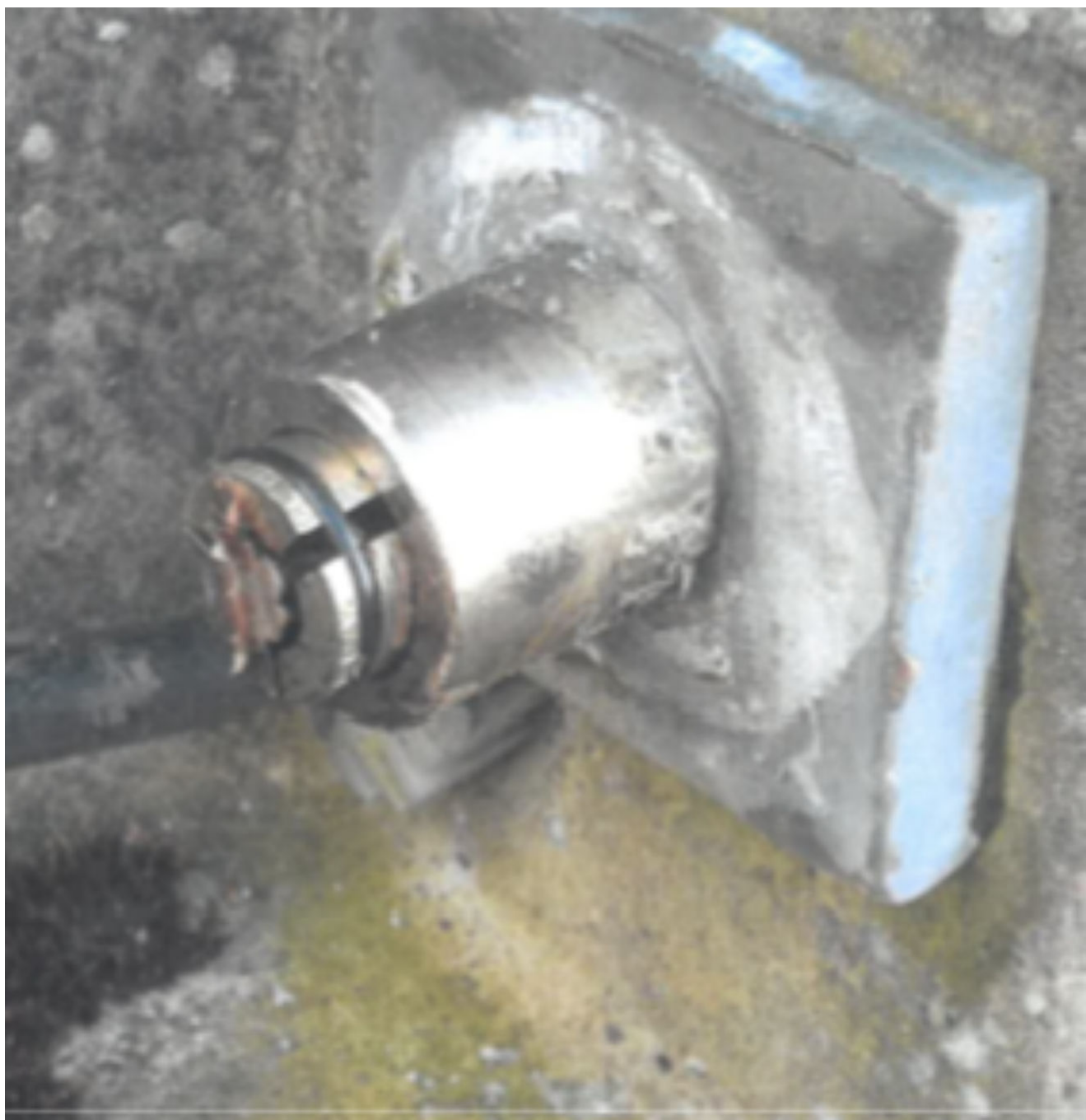
Foto 6. Kabellås (CCL lås- – sådan skal den se ud under hættten).
