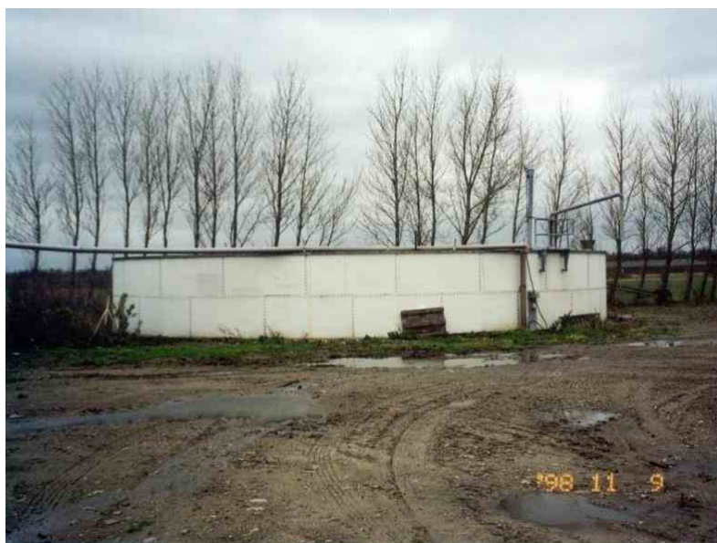
Foto 23: Stålbeholder med væg af flade profiler. Beholderen har fundament under terrænniveau.
