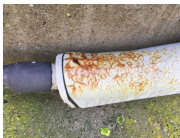
Foto 22. Større grad af overfladerust og revner i låsens overfladebehandling.
