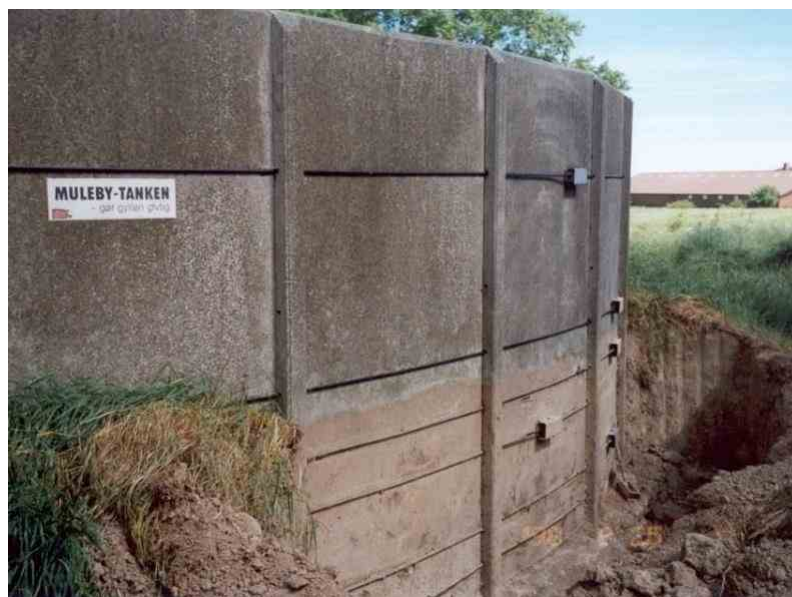
Foto 13: På de ældste Muleby beholdere er opspændingen sket med spredte opspændingsstykker.
