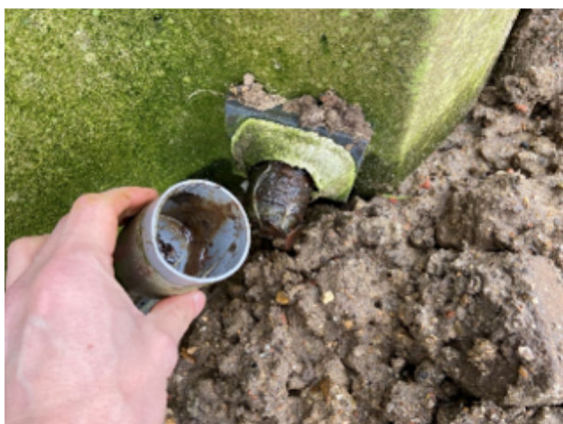
Foto 17. Afdækning på Perstrup beholder, hvor fugemassen er udtjent og der ses vand stående i hættten.
