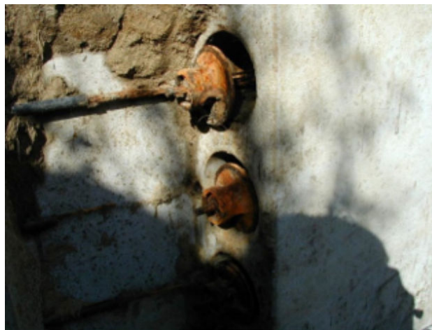
Foto 30. Låse hvor der ses korrosion på låsehuse og ingen overfladebehandling.
