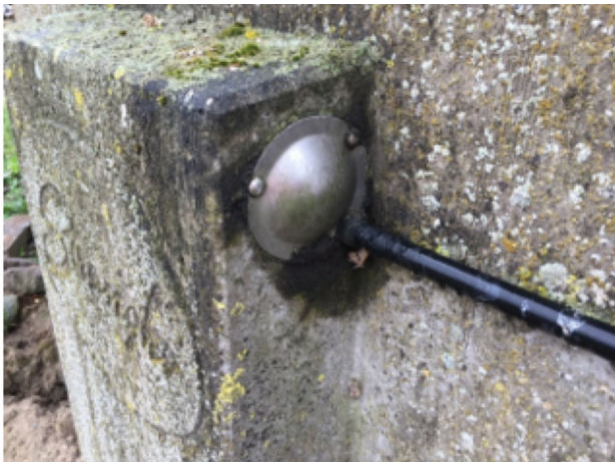
Foto 13. Afdækning på Spæncom beholder i form af ståldækning med pakning.
