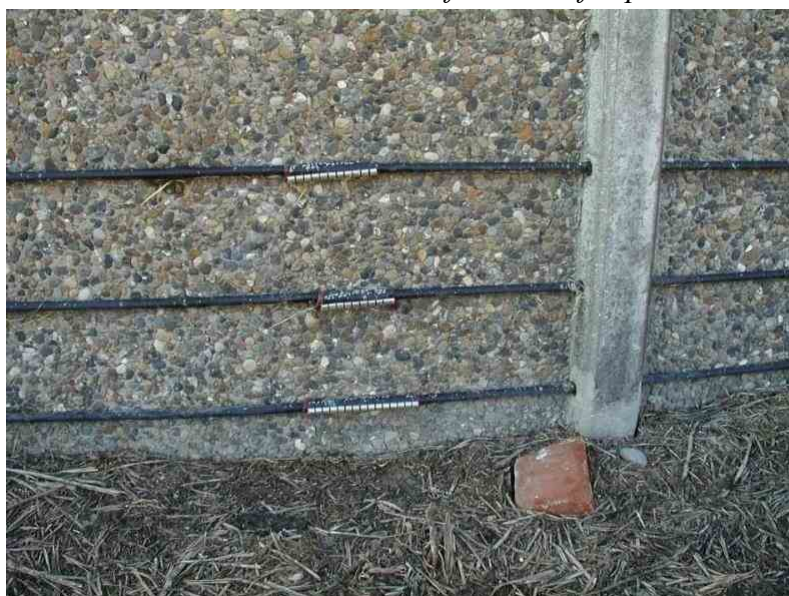
Foto 41: Her er huller i tre kabler, der er udbedret.
