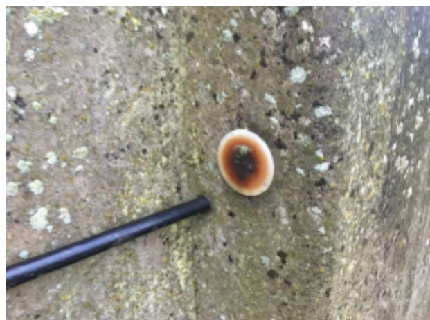
Foto 18. Afdækning på Tørring beholder, hvor der ses rustdannelse under afdækningen.
