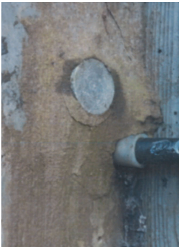
Foto 25. Indstøbt forankring/lås.
