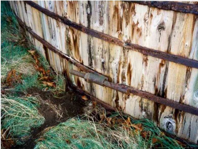
Foto 27: En beholder af træ. Den består af lodrette imprægnerede træstave sammenholdt med spændebånd. Bundplade af beton er i terrænniveau.
