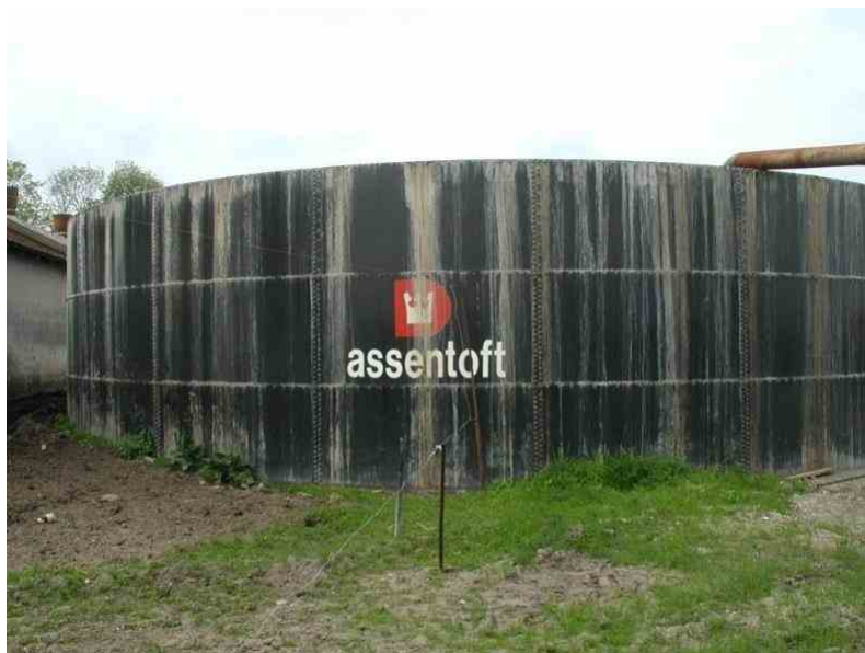
Foto 21: Stålbeholder med væg af glatte profiler. Beholderen har fundament i terrænniveau.
