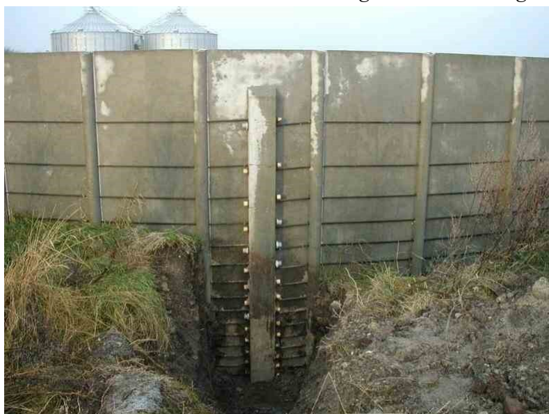
Foto 8: TC-tanken findes i få eksemplarer fra 1994-95. Den har udvendige kabler. Beholderen har låseelement til
