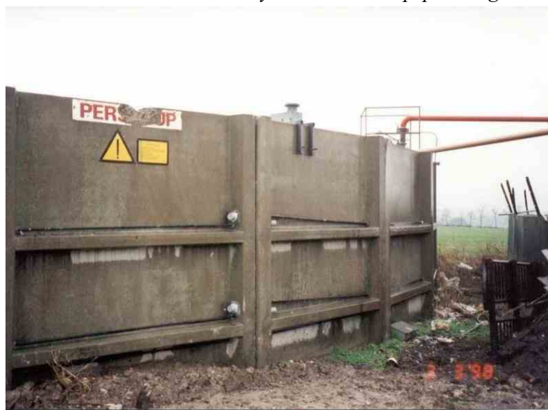
Foto 13: På de ældste Muleby beholdere er opspændingen sket med spredte opspændingsstykker.
