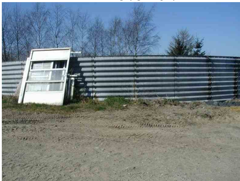
Foto 21: Stålbeholder med væg af glatte profiler. Beholderen har fundament i terrænniveau.
