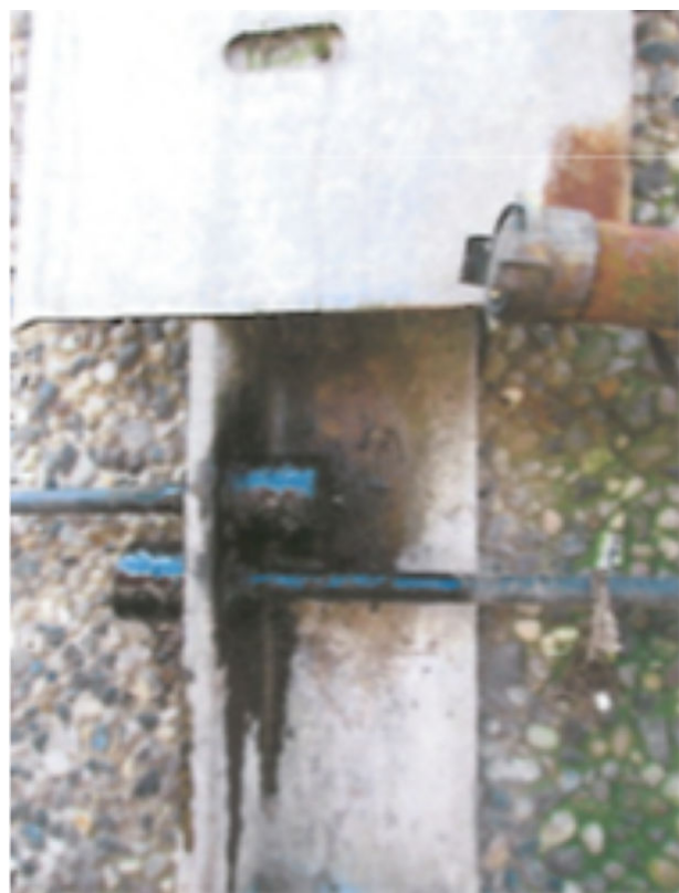
Foto 28. Låse afdækket og smurt med korrosionsbeskyttelse.
