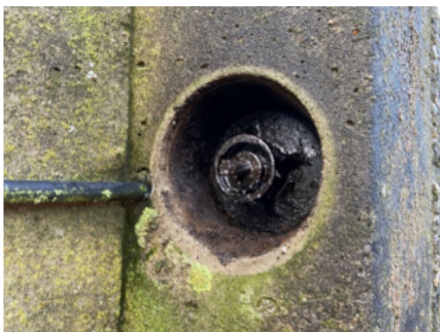
Foto 27. Lås på Muleby beholder med dækkende overfladebehandling.
