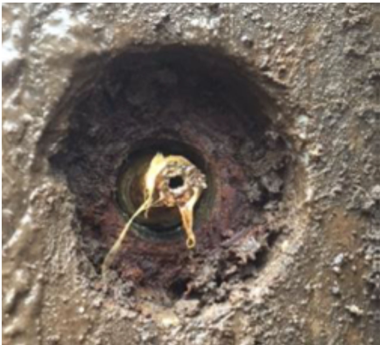
Foto 2. Tegn på defekt kabel (hjertekordellen er sunket ind).
