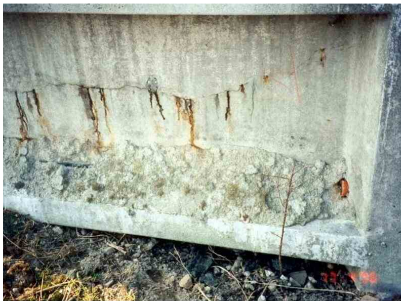
Foto 45: Hvis der siver gylle gennem revnen som her skal der ske en tætning og udbedring på beholders inderside.
