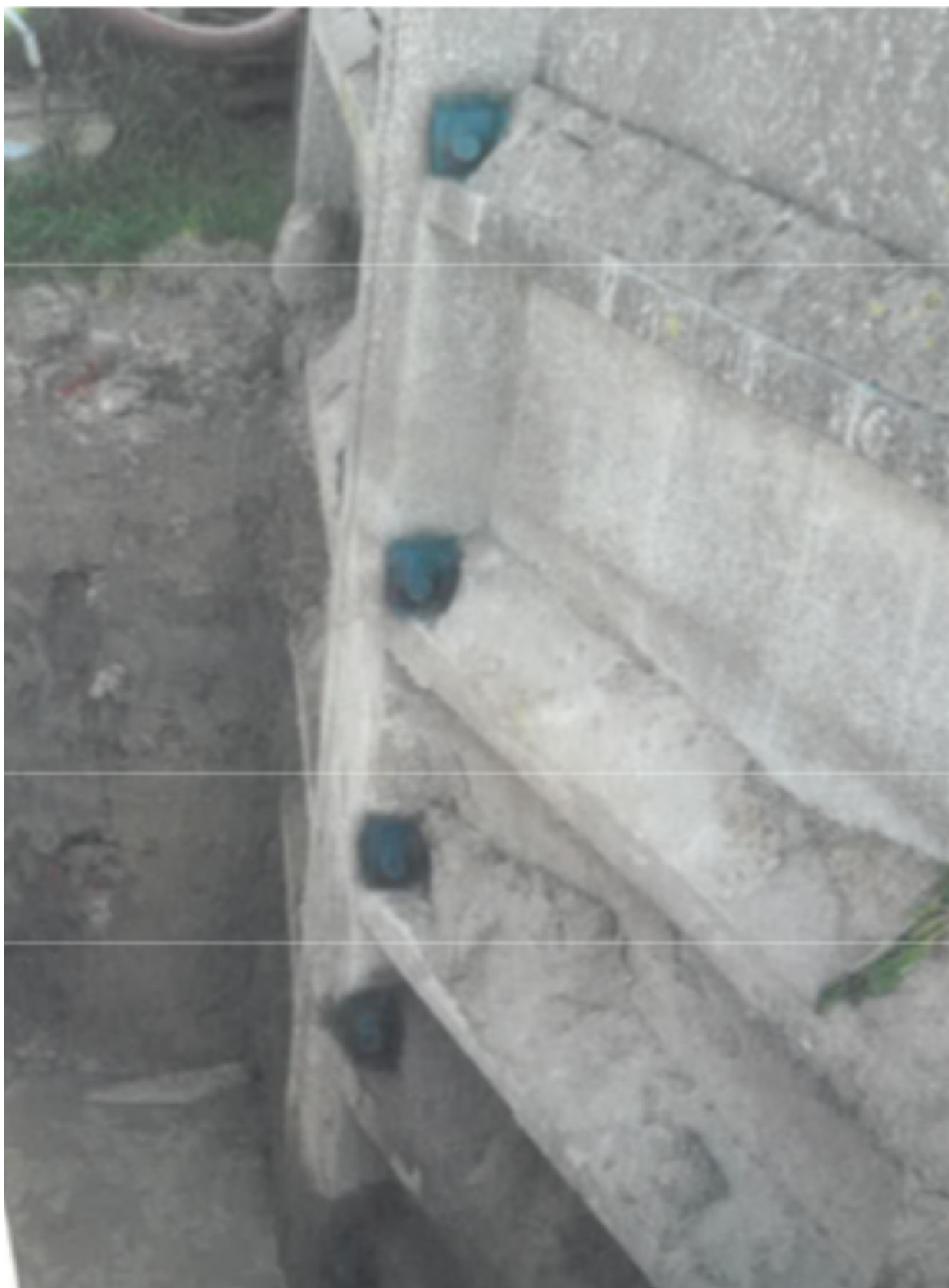
Foto 8. Ved overstøbte kabler (Perstrup beholder) kan der være behov for at hakke fri omkring lås.
