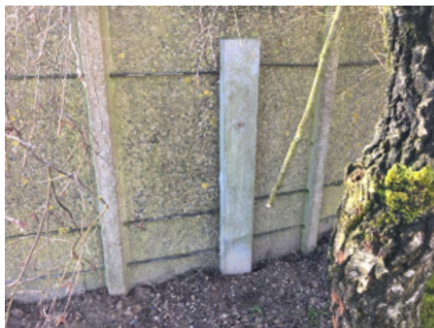
Foto 33. Afdækning af låse med stålskinne.
