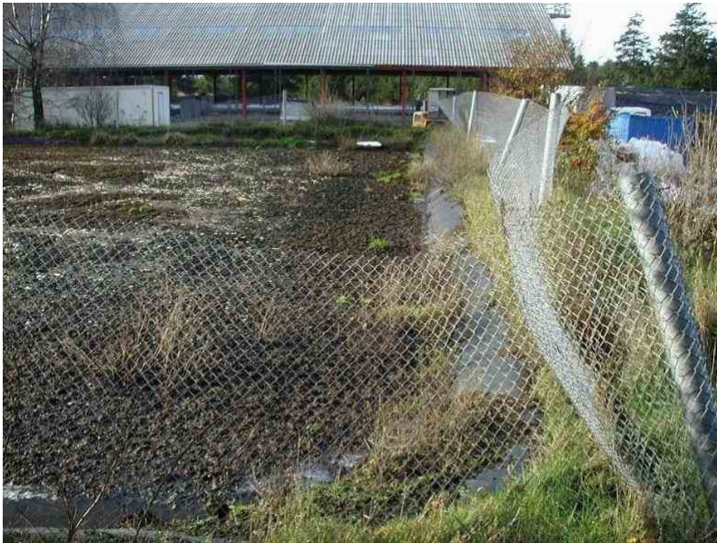
Foto 29: Betonlagune. Denne lagunetype har normalt nedkørsel. Den skal kontrolleres, hvis den kan indeholde over 100 m 3 flydende gødning.
