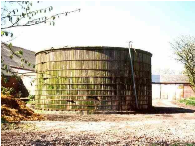
Foto 27: En beholder af træ. Den består af lodrette imprægnerede træstave sammenholdt med spændebånd. Bundplade af beton er i terrænniveau.
