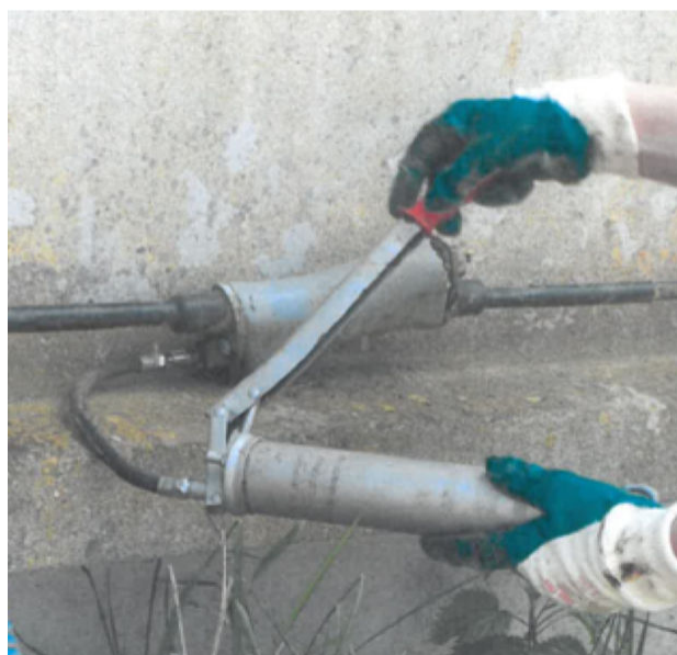
Foto 20. Efterfyldning af Dywidag lås med fedt.
