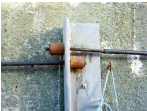
Foto 29. Låsehuse på jernskinne, hvor der ses korrosion på låsehuse og ingen overfladebehandling. Desuden ses manglende kabelbeskyttelse.
