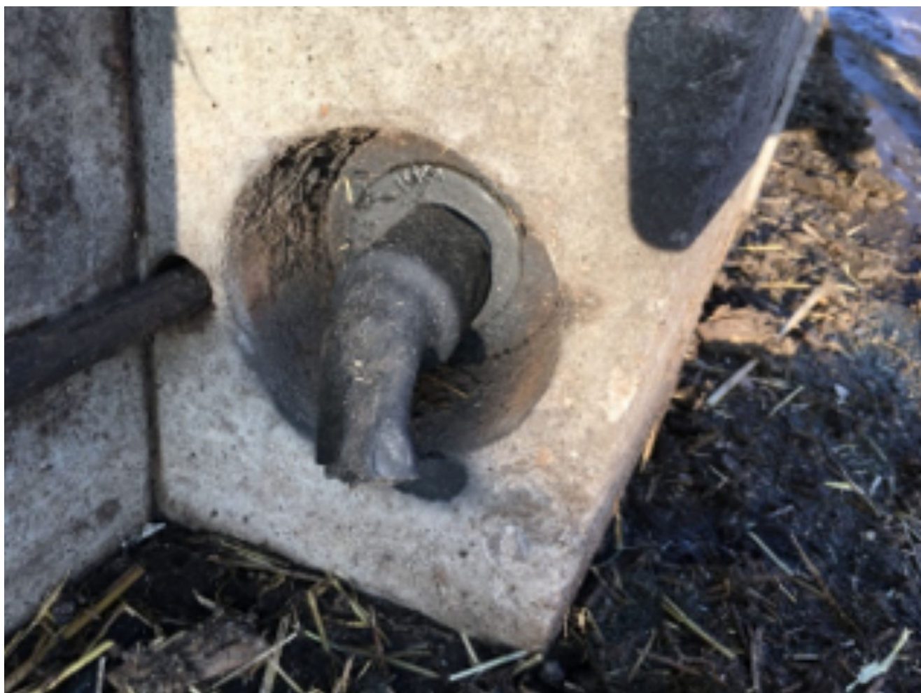
Foto 5. Alternative afdækninger end de oprindelige, her i form af en krympeflex, sat ud over låsehuset, anbefales ikke.
