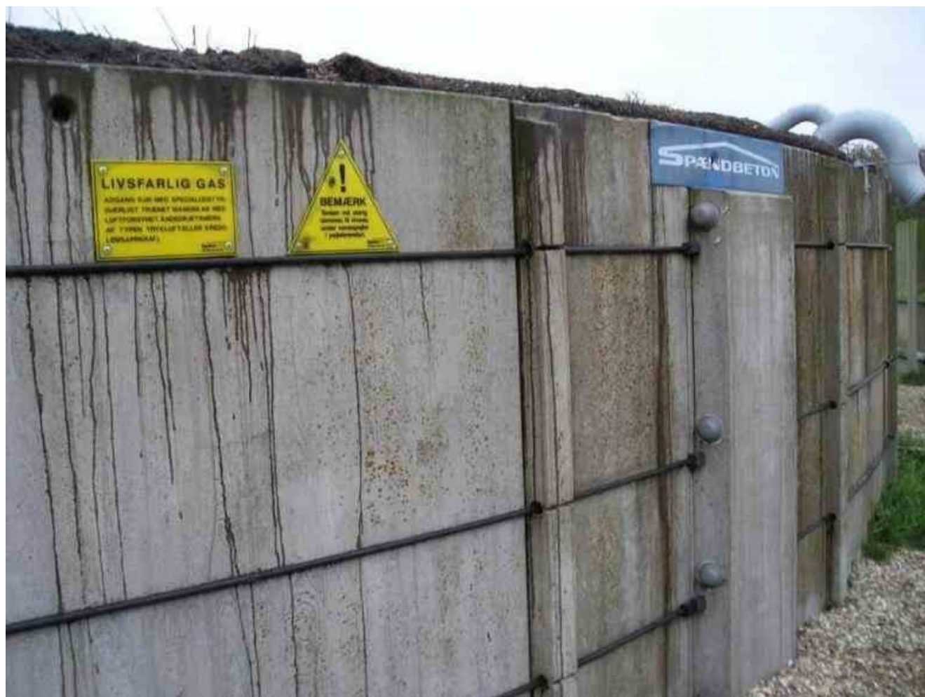
Foto 6: Beholdere fra Spæncom har udvendige kabler. Beholderen har låseelement til fastholdelse af kabler
