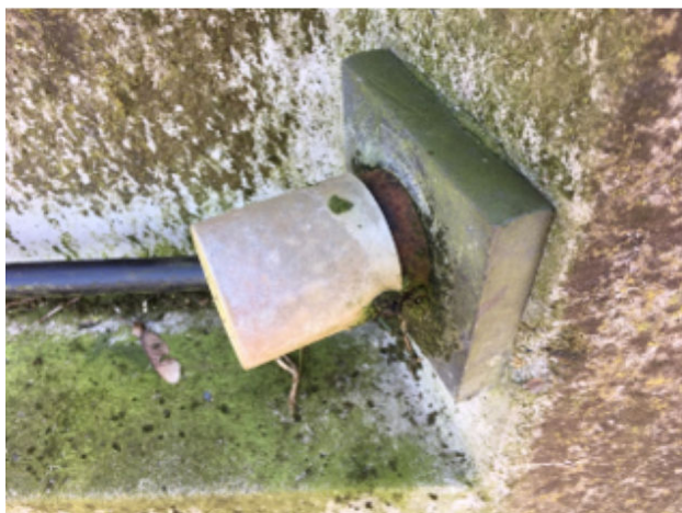
Foto 15. Afdækning på Perstrup beholder, hvor fugemassen mangler og der ses korrosion på låsehuset.
