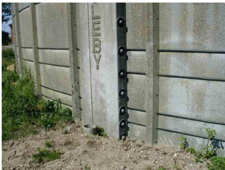
Foto 11: På billedet ses låseelementet på en nyere Muleby beholder. Låseelementet er skjult af en rund plastafdækning.
