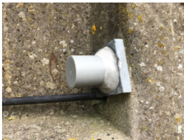
Foto 10. Afdækning på Perstrup beholder i form af plasthætte som sættes i en fugemasse. Stålpladen er galvaniseret.
