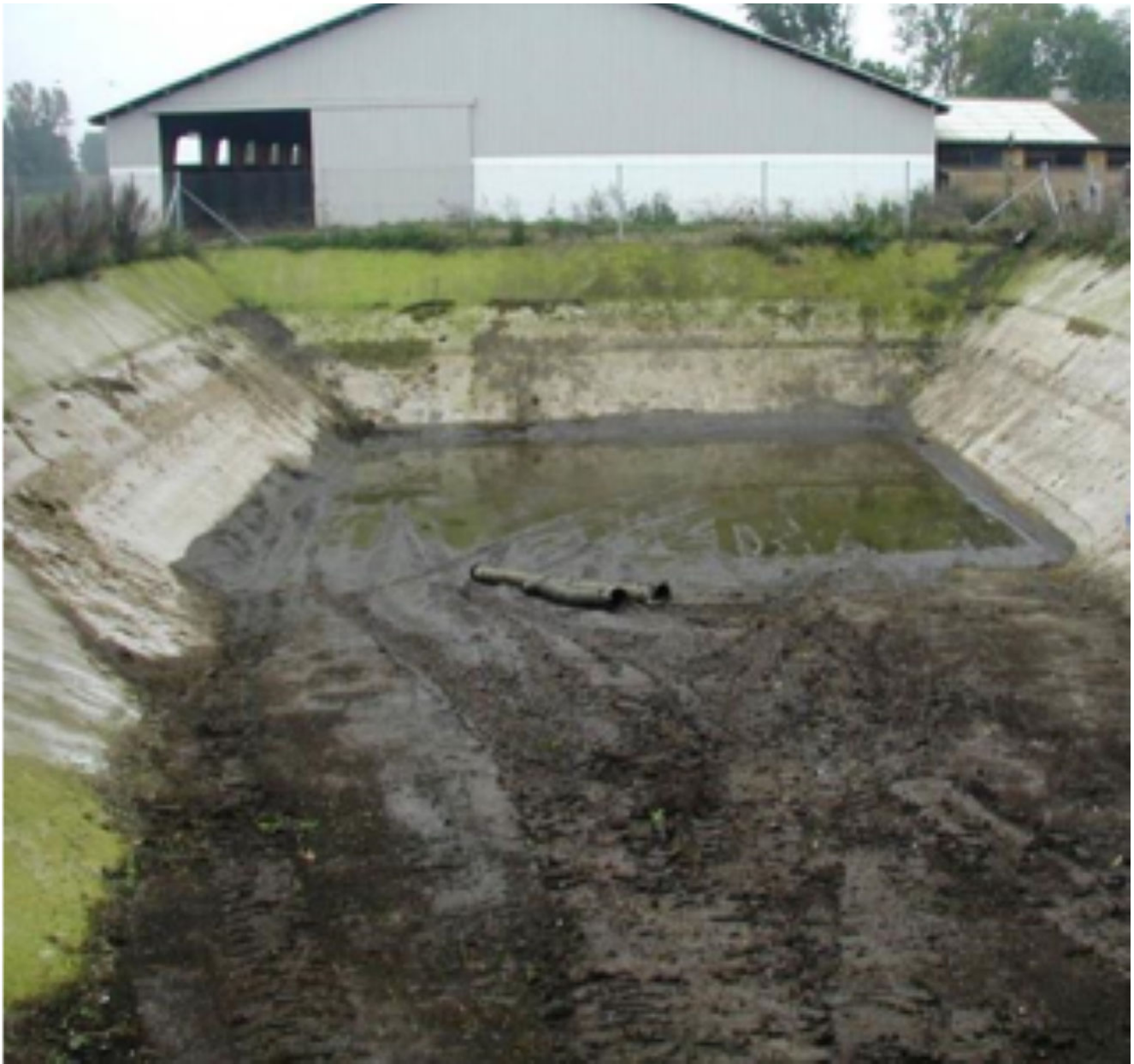
Foto 31: Lagune af fiberbeton.
