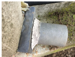
Foto 16. Afdækning på Perstrup beholder, hvor fugemassen er udtjent og der ses fugeslip til stålpladen.
